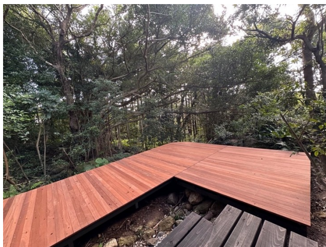
コモンズのデッキ。施工：Inahokobo 写真：Bobby Anderson
